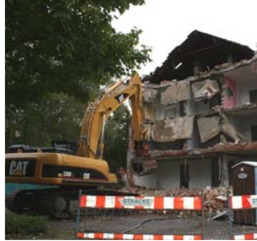
Dirschauer Str. 36 - 38 in Witten-Annen (Abrissarbeiten)
