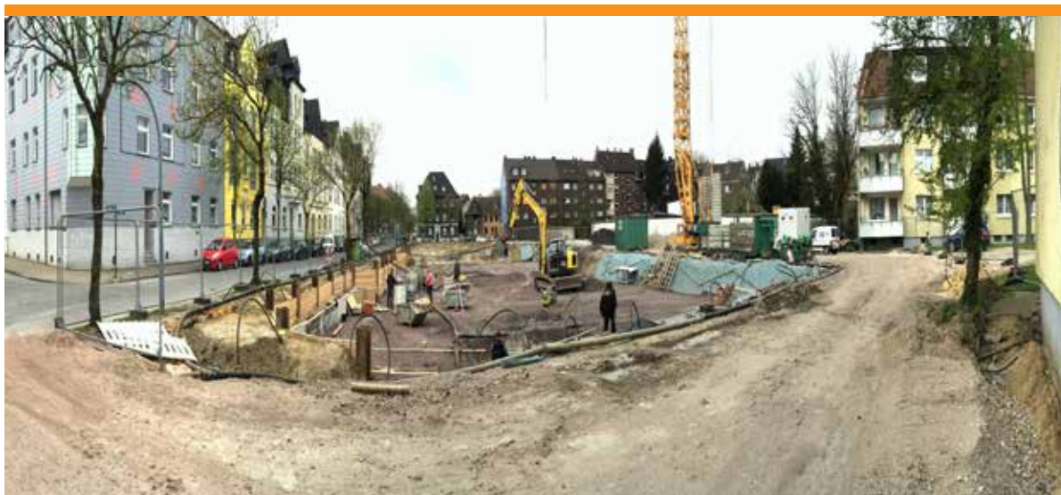
Baugrube an der Jobststraße (Stand April 2015)
